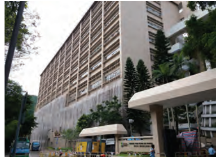
In progress 翻新中
