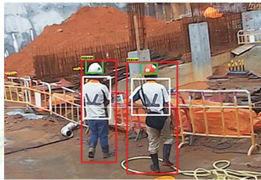
▲ 電腦視覺能辨認到工人、反光衣及頭盔的異常狀況。
