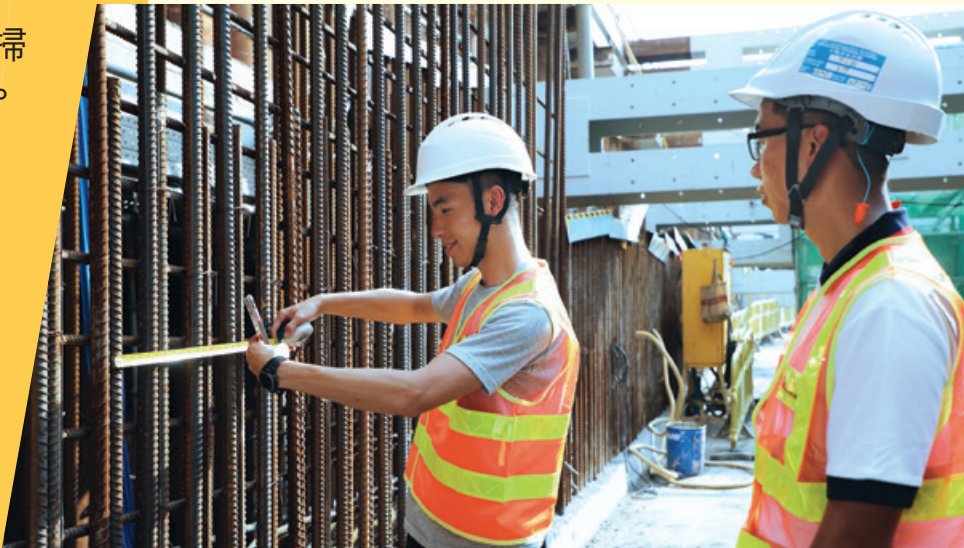
▲ 承建商、顧問同業主可以喺Inspecto一齊共同監察
