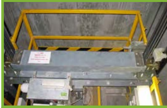
圖 15 (9.1.8b): 升降機機廂頂必須提供安全圍欄及踢腳板
