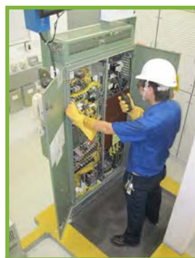
圖 14 (8.8.5d): 升降機工程人需穿上合適的保護裝備及絕緣手套 / 靴子，並站在絕緣地蓆上進行帶電工作
