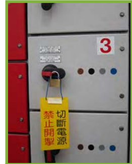
圖 12 (8.5.3c): 隔離電力的來源及適當 上鎖/掛牌
