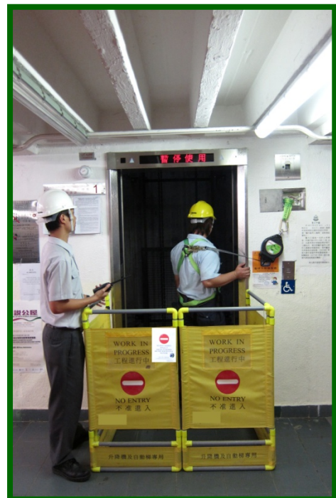
圖 1(8.2.1e): 提供升降機槽的安全進出口
