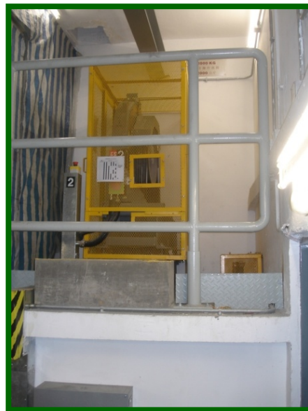
圖 6(8.5.2d): 在高處的工作平台應安裝適當護欄及踢腳板
