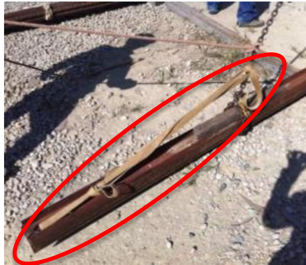
穩固物料末端 “制頭制尾” 保持平衡
