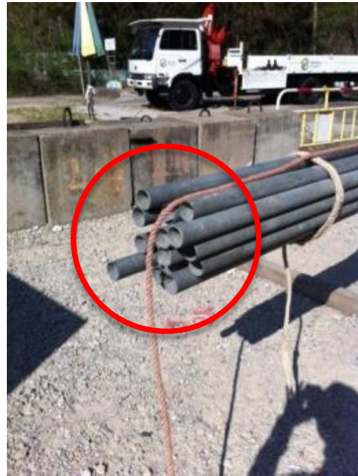
穩固物料末端 “制頭制尾” 保持平衡
