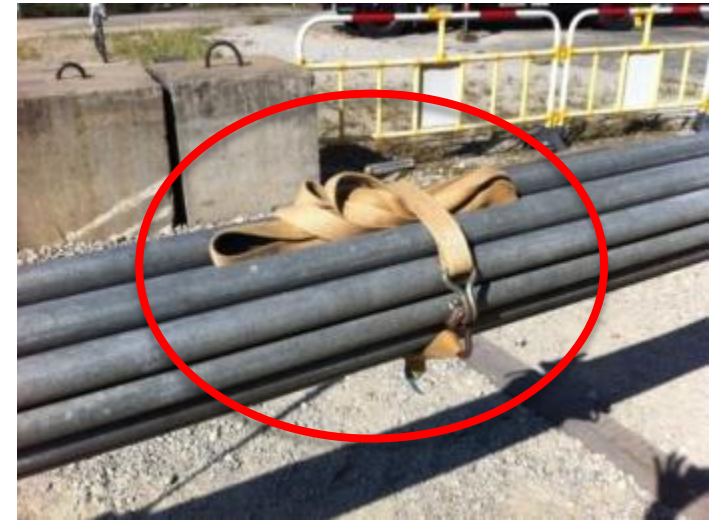
利用索帶“飛機帶” 於長物料中間加以 穩固數條物料
