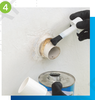
4 在管身外面及配件內部塗上適量已批核的黏合劑
