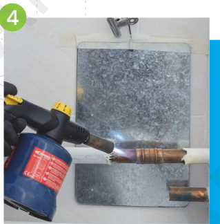
4 進行喉管焊接
