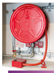
現場施工實物成品
