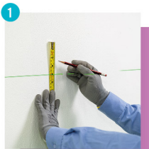
根據施工圖則測繪模組背架的安裝位置與尺寸
