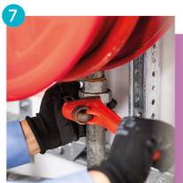
7 完成消防喉拉轆供水管道的接駁工作
