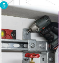
5 將預製的水錶模組安裝於水錶房指定位置
