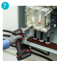
安裝上升總線及餘下線槽
