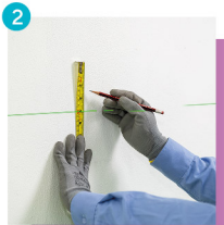
2 根據施工圖則測繪模組背架的安裝位置與尺寸
