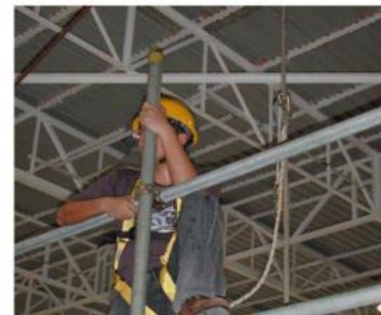
照片五：使用繩索夾頭及垂直獨立救生繩進行金屬棚架搭建或拆卸工作
