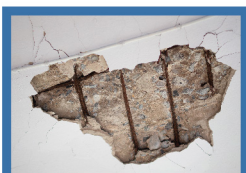
混凝土剝落
