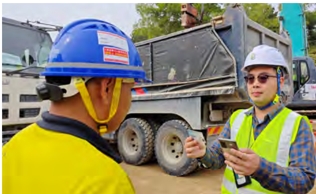
巡查及執法隊巡查建造工地
