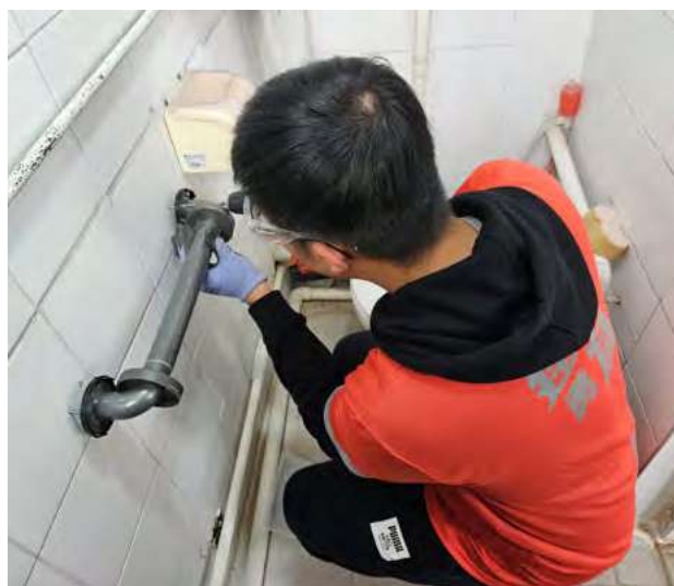
建造業義工服務日 – 建造業義工隊為長者安裝扶手
