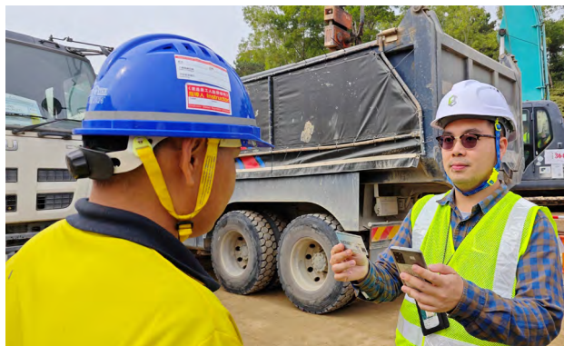
巡查及執法隊巡查建造工地
