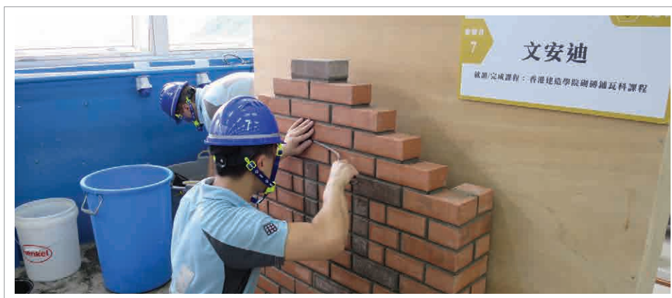
Hong Kong Construction Youth Skills Competition 2018 2018年香港建造業青年技能大賽
