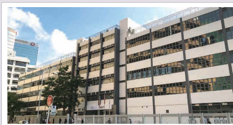
After renovation 外牆翻新工程後
