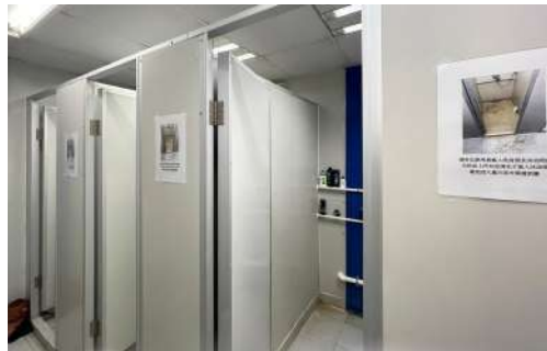
組裝工地淋浴設施
