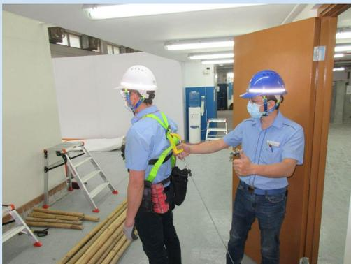
棚工拆卸前應檢查及維修棚架，並由合資格人仕確認棚架安全後才拆卸棚架
