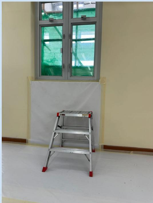
棚工鑽孔安裝鋼托架前需使用防塵
